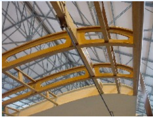
Une vue rapprochée de la structure de l'aile du Blériot XI
